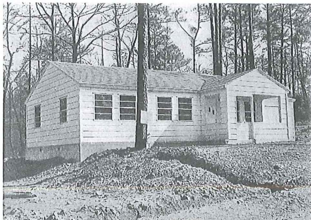
Moderne engelsk elementhus af aluminium. Ved profilering af pladekanterne (udføres på fabrik) fastlåses beklædningspladerne til hinanden under opsætningen
